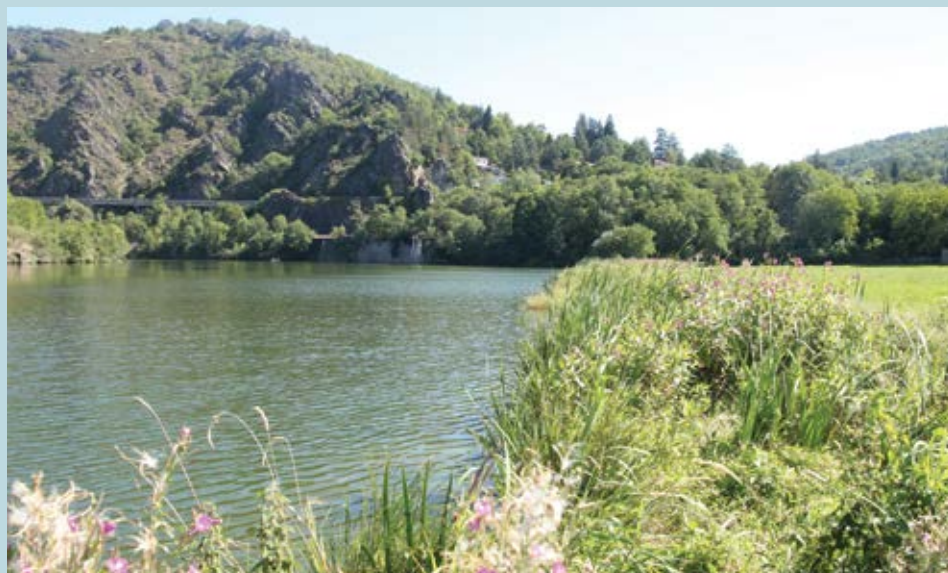
Barrage de Grangent - A. Ulmer
